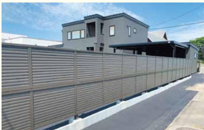
隙間のないフェンスでプライバシーを確保したいとお庭を囲うようにフェンスを取付けました。フェンスの隙間からボール等が転がないよう土留で止められるよう工夫されています。
