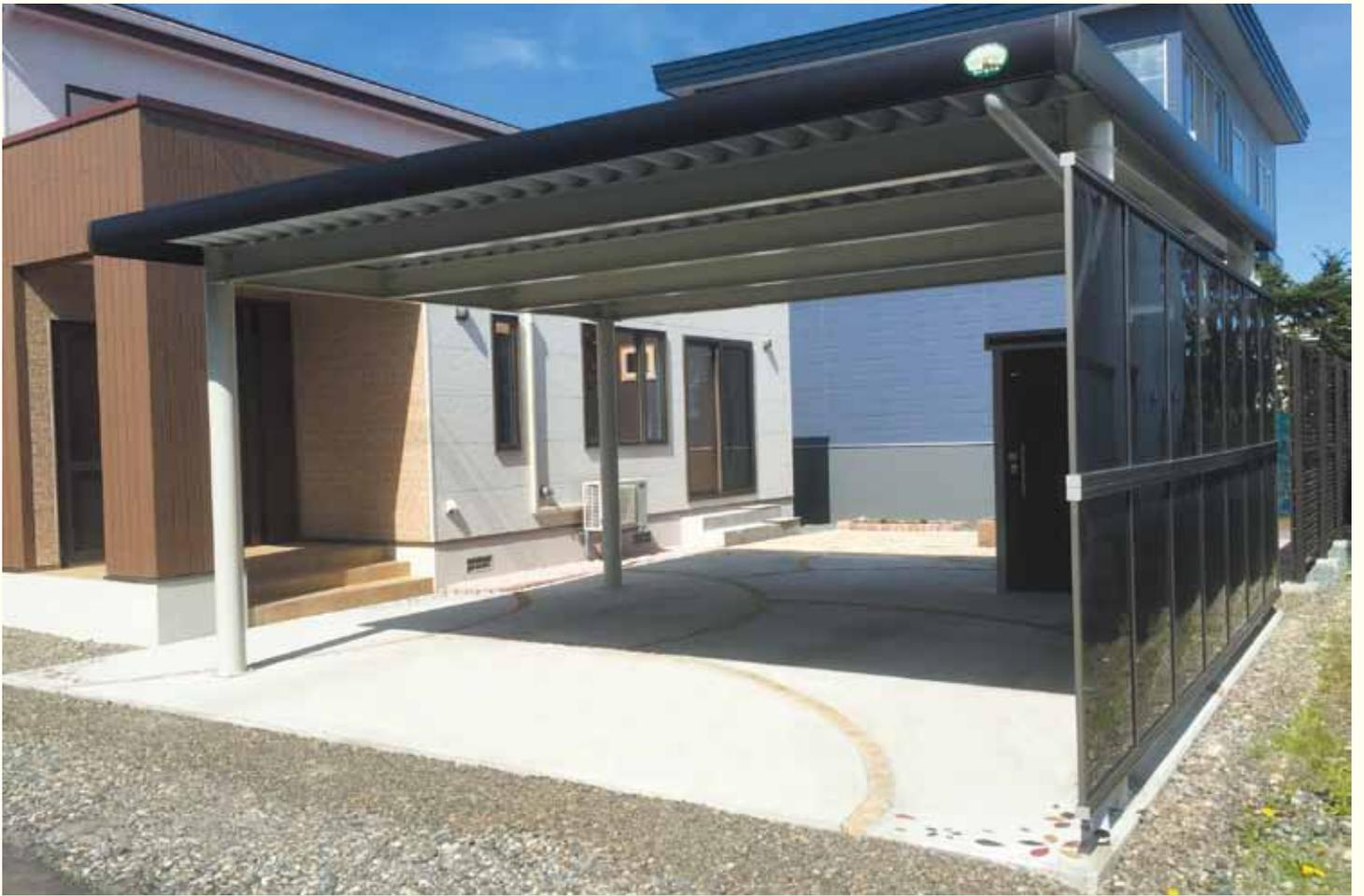
コンクリート舗装にピンコロ石を虹の形に施工しました。カーポートにはサイドパネルを付けて向いの家からの目線をカット。冬の吹雪での積雪も軽減できます。カーポート・フェンス・物置・土留とブラウン系の色で家との調和も考えました。
